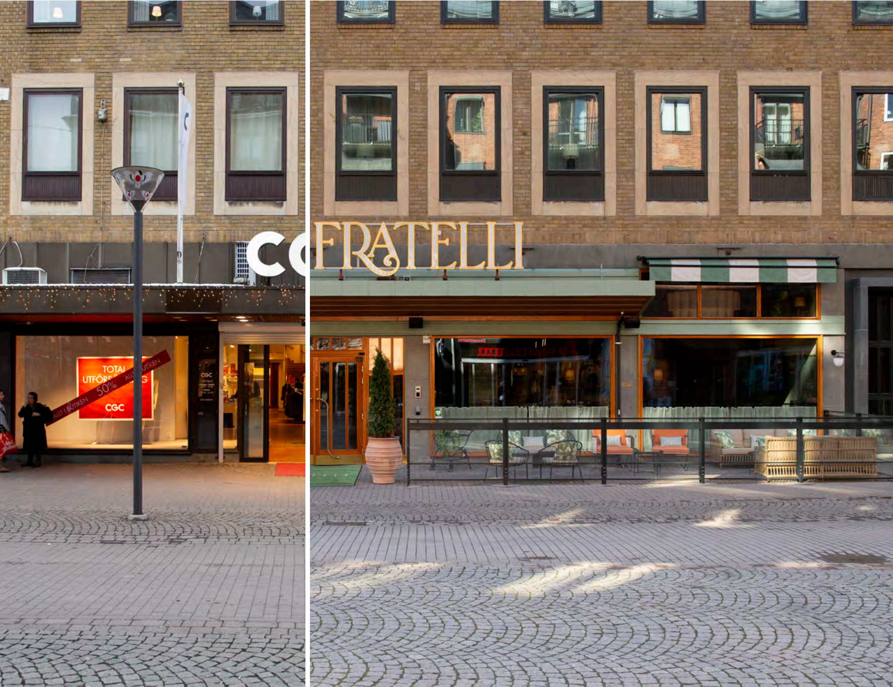
Före och efter ombyggnaden av "CGC-huset", Duvan 7, Karlstad.
