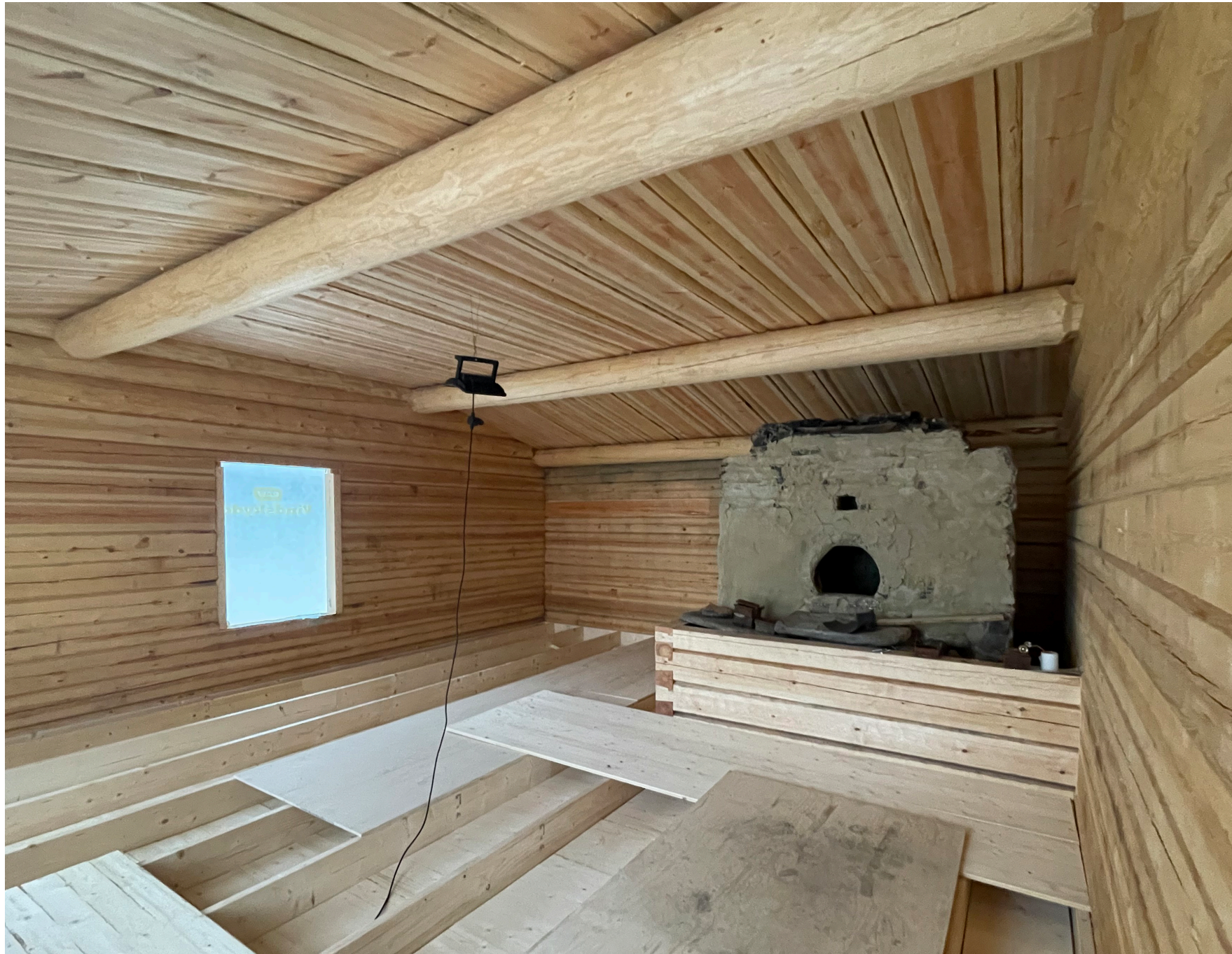
Den återuppbyggda rökstugan i Mattila.
