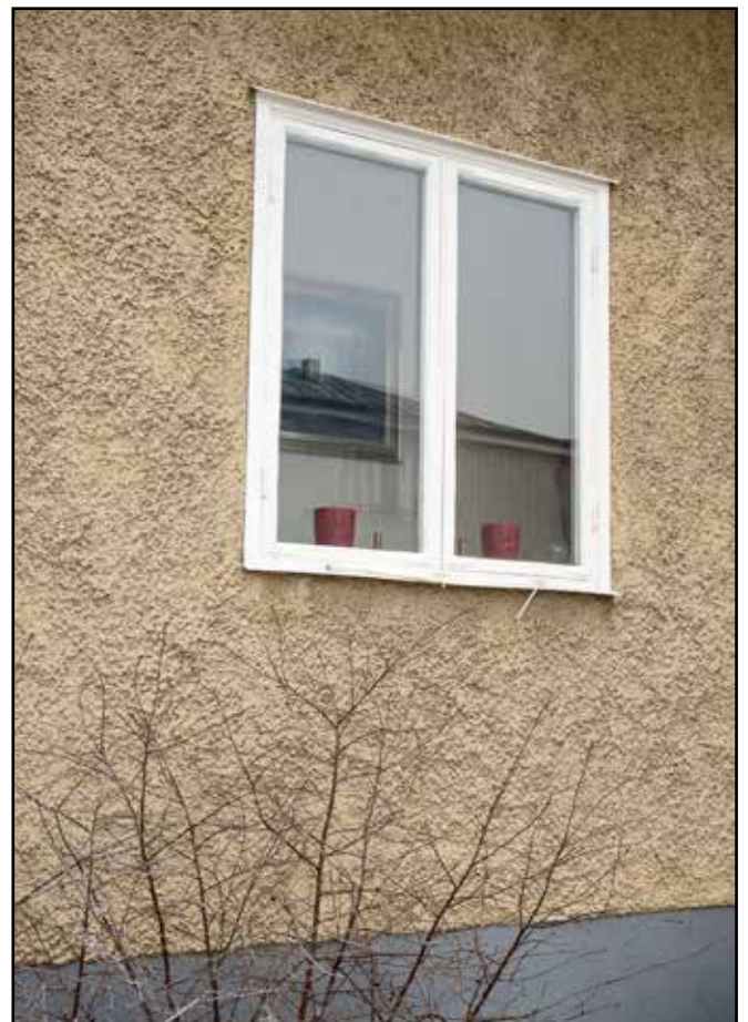
Med 1930-talet kom de ospröjsade, stora glasytorna. Fönstret placerades i liv med fasaden och utgjordes ofta av två stående lufter.
