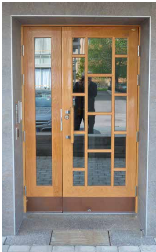
Exempel på väl anpassat utförande vid utbyte till ny port utförd i ädelträ.
