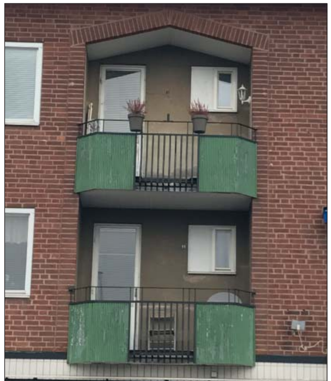
Träport med bevarade beslag och detaljer som husnummer med belysning (överst). Balkonger med både plåtfrent och smäckert smide inramas av en gavelformad tegelram (underst).
