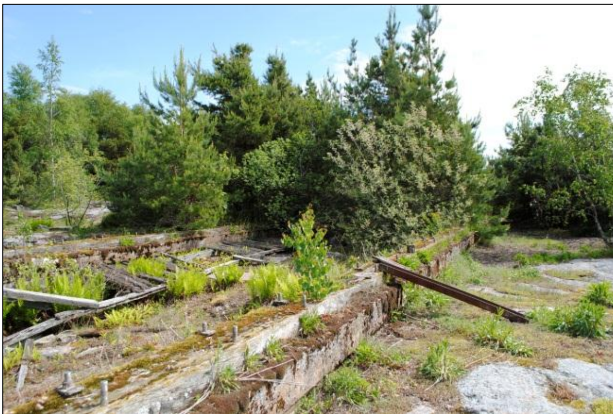
Delar av den gjutna konstruktionen på Garpen.
