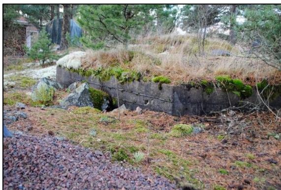
Ovan: Gjuten källare. Nedan: Öppen tvställning i betong.
