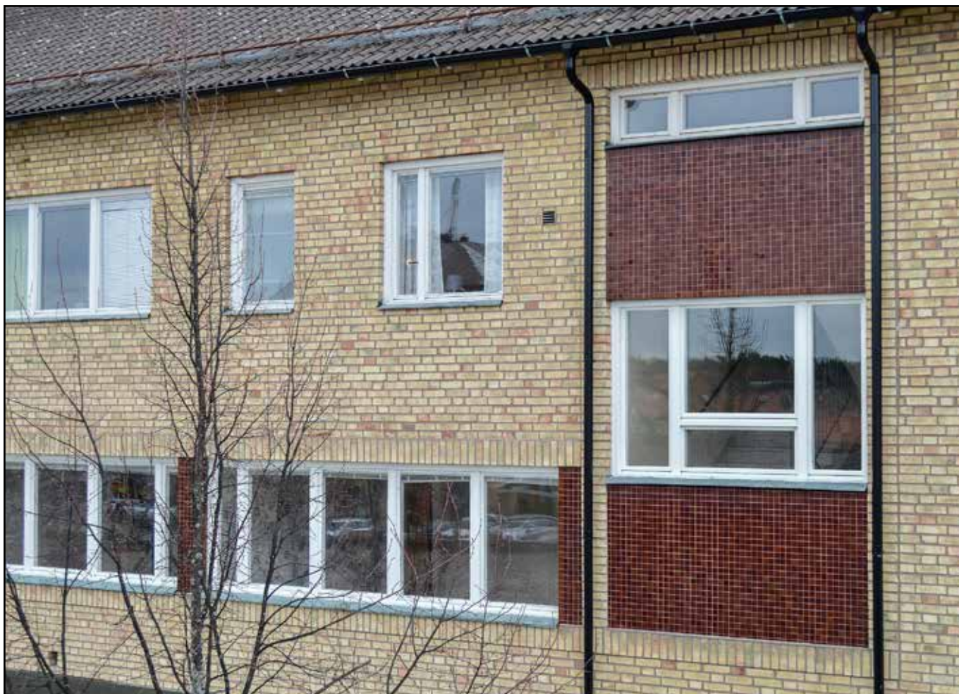
En provkarta på vanliga arrangemang och indelningar av fönster kring 1900-talets mitt. Huvudluft med liten sidoställd vädringsluft i översta våningen, långa fönsterband i våningen under. Det mosaikklädda trapphuset till höger visar exempel på variationsrika fönsterformer.
