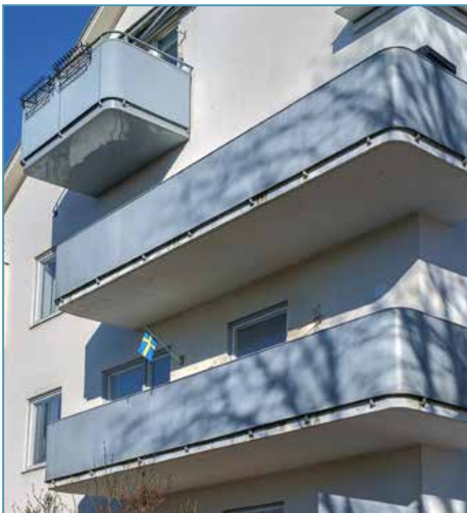
1930-talets balkonger hade ofta släta fronter och sträckte sig kring byggnadens hörn.
