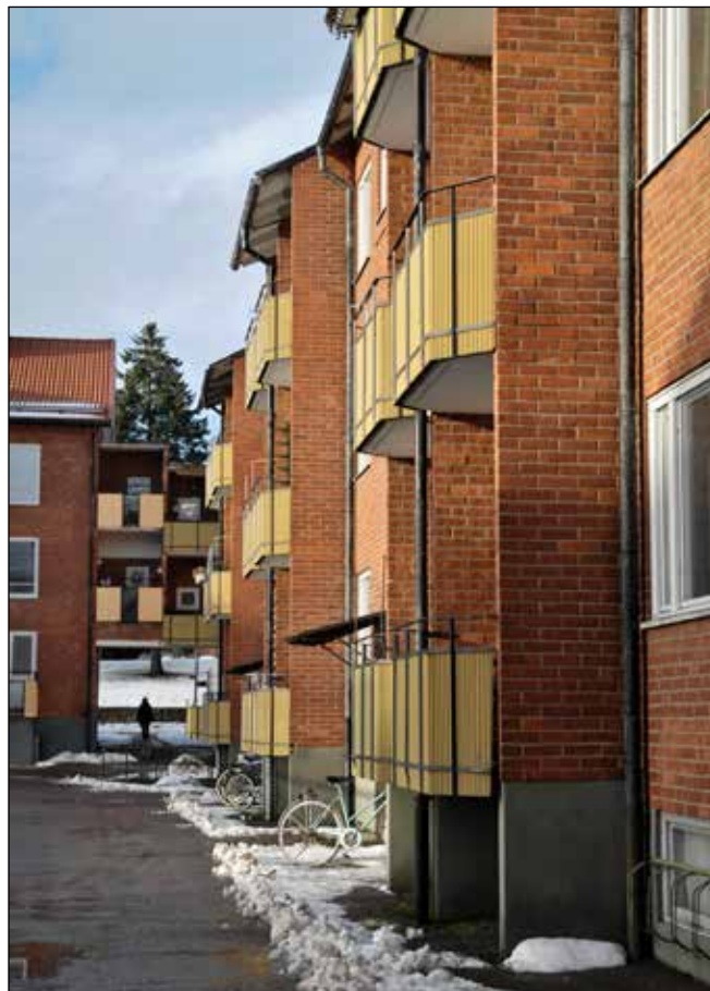
1960-talets balkonger var ofta antingen helt indragna så att de hamnade i liv med fasaden, eller som här omgivna av sidoskärmar.
